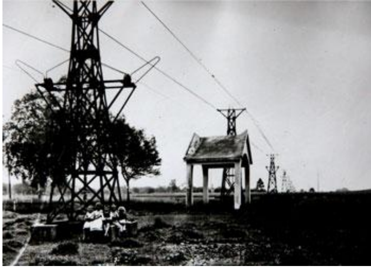
Masten der Materialseilbahn Großweil-Kochel um 1920. In Bildmitte eine Schutzbrücke aus Beton über die Landstraße.
